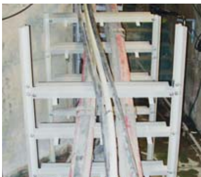
Sestavení kabelové nosné konstrukce ve stísněných prostorách podzemního kolektoru
