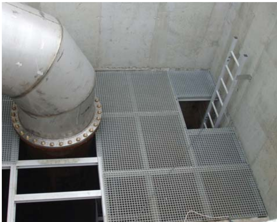
VÝSTAVBA PODESTY – ŠACHTA BRNO, PISÁRKY
