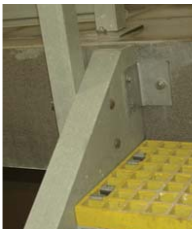
KOTVENÍ SCHODNICE
