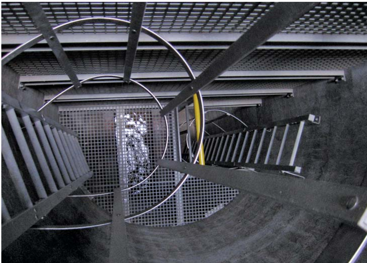
ŽEBŘÍKY V LEZNÍ ČÁSTI ŠACHTY – PRAHA, UL. VÝSTAVNÍ
