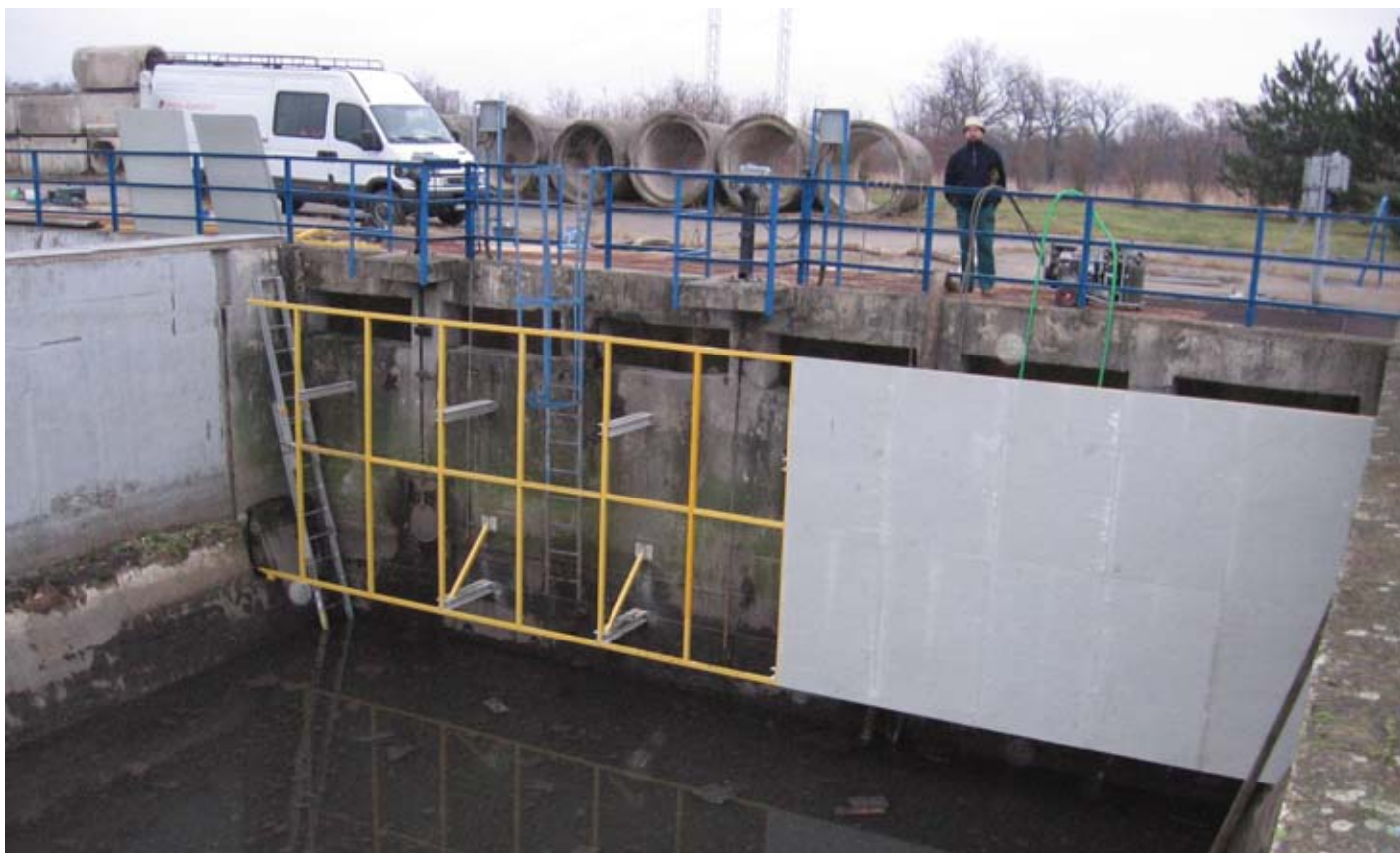
NORNÁ STĚNA – DEŠŤOVÁ USAZOVACÍ NÁDRŽ PRAHA STODŮLKY
