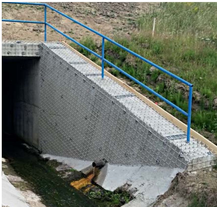
KOMPOZITNÍ SÍŤ PRO SANACI STĚN - POLDRY LUKA NAD JIHLAVOU
