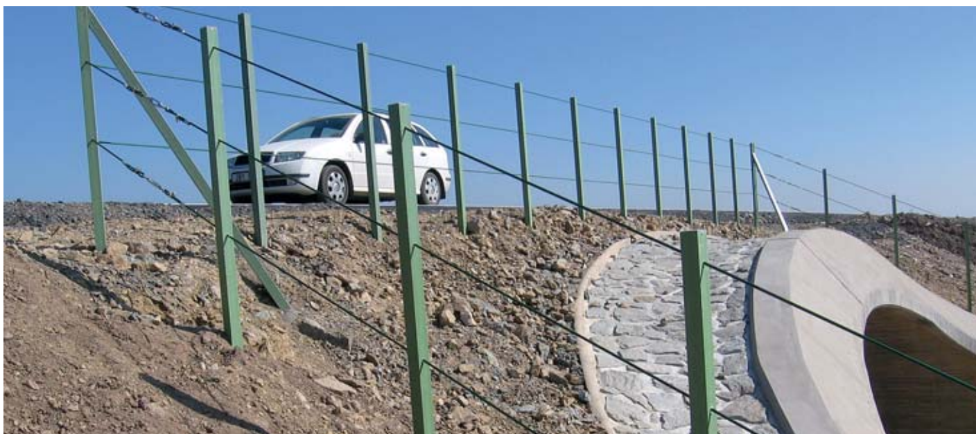
LANKOVÉ ZÁBRADLÍ – D8
