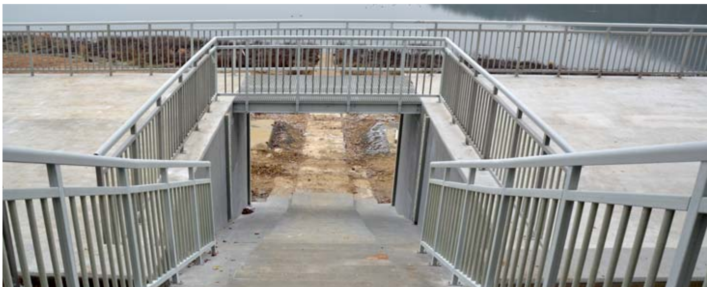
ZÁBRADLÍ SE SVISLÝMI VÝPLNĚMI – VODNÍ DÍLO RUŽINÁ
