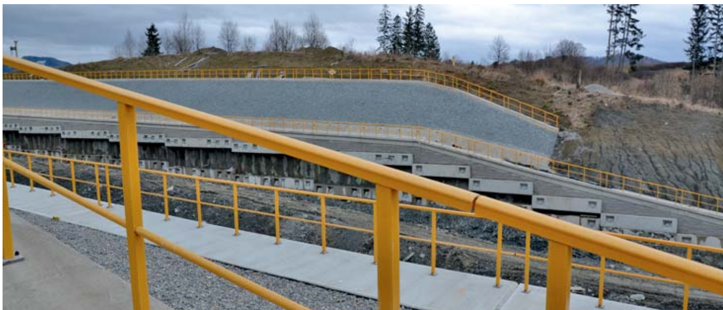
ZÁBRADLÍ S VODEROVNÝMI VÝPLNĚMI – D1 LIETAVSKÁ LÚČKA
