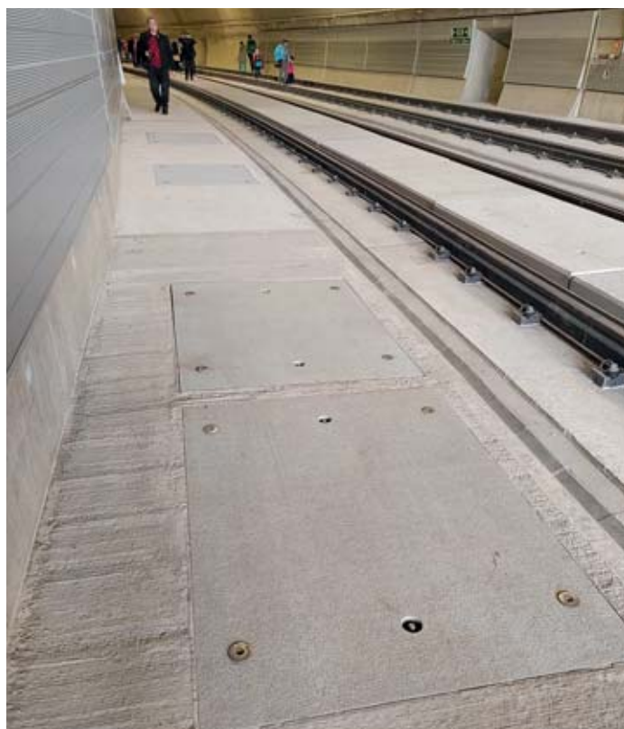
ZÁTĚŽOVÉ POKLOPY C250 – TRAMVAJOVÝ TUNEL BRNO ŽABOVŘESKÁ
