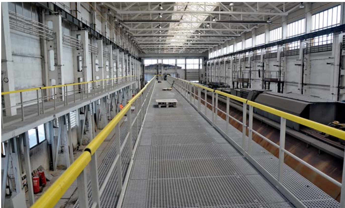
VÝSUVNÉ ROŠTY A ODNÍMATELNÉ ZÁBRADLÍ – ŽELEZNIČNÍ DEPO BOHUMÍN
