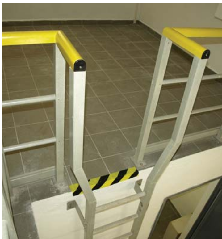
ROZŠÍŘENÝ VÝLEZ S NAPOJENÍM NA ZÁBRADLÍ
