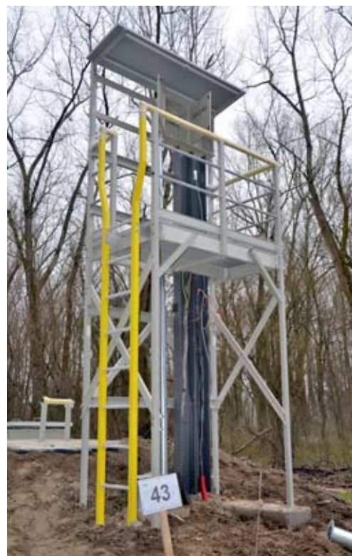
OBSLUŽNÁ PLOŠINA – BRATISLAVA VODNÍ ZDROJ SIHOŤ
