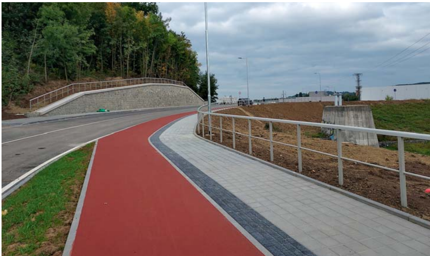
ZÁBRADLÍ S VODOROVNÝMI VÝPLNĚMI – CYKLOSTEZKA KUŘIM ZÁHOŘÍ
