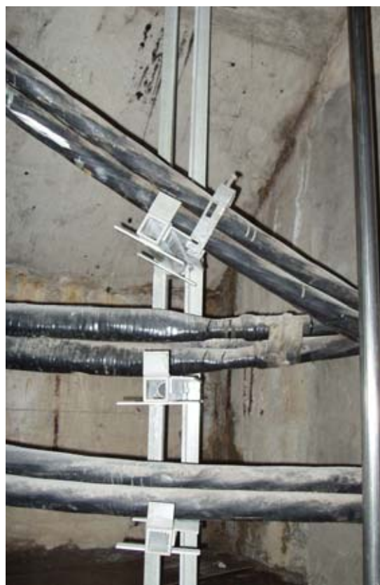
NOSIČE S POLOHOVACÍMI VÝLOŽNÍKY – KOLEKTOR PRAHA
