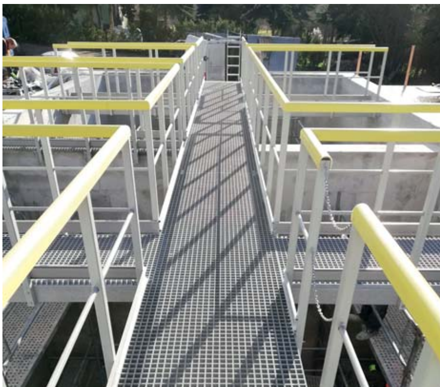
LÁVKY PŘES NÁDRŽE – ČOV ÚJEZD NAD ZBEČNEM
