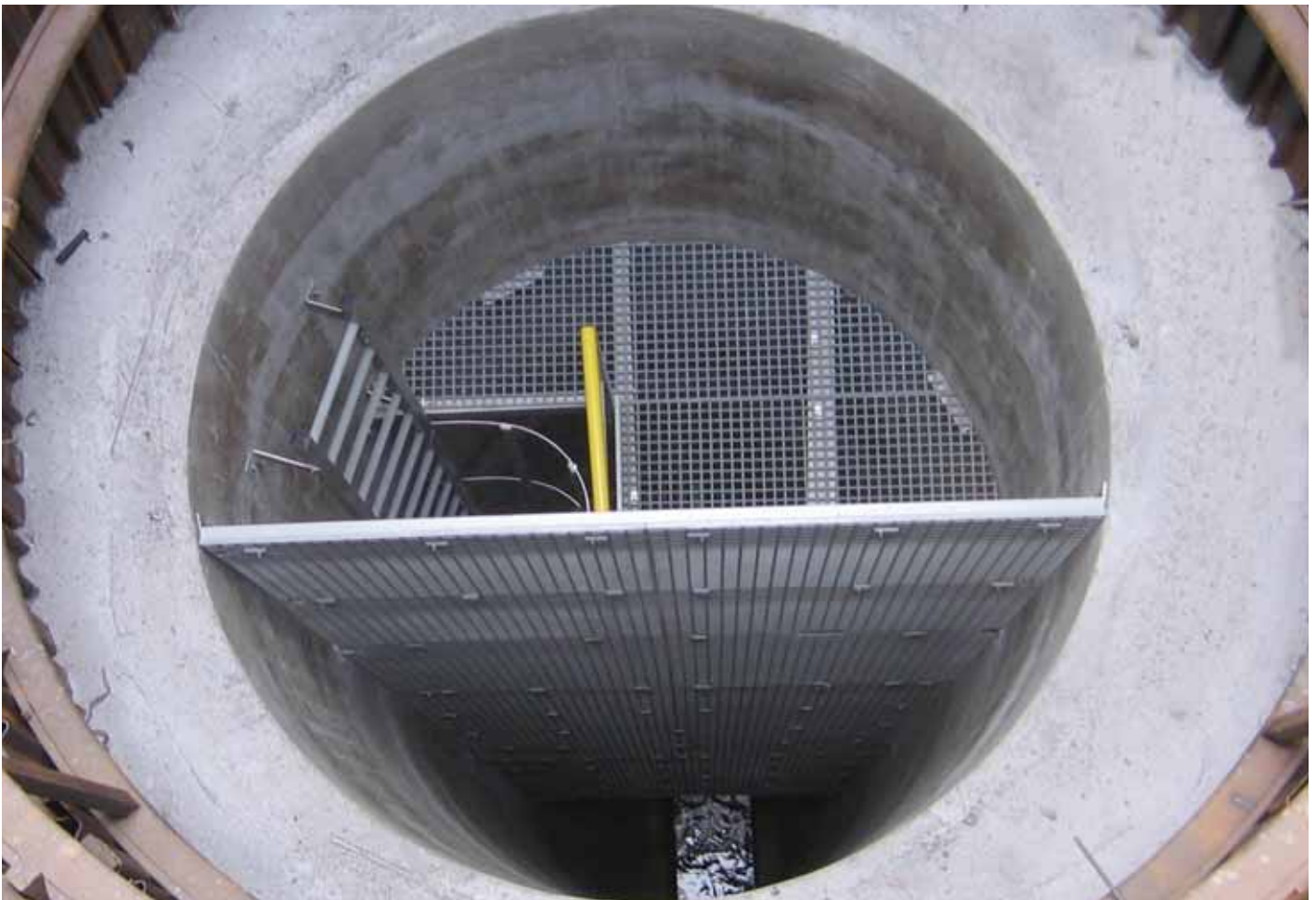
SHAFT ACCESS EQUIPMENT INCL. DIVIDING WALL – SHAFT IN VÝSTAVNÍ STREET, PRAGUE, CZECH REPUBLIC
